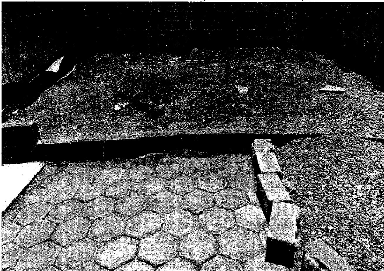
Foto 1 - Trecho no final da Rua Lindolfo Teodoro de Melo
